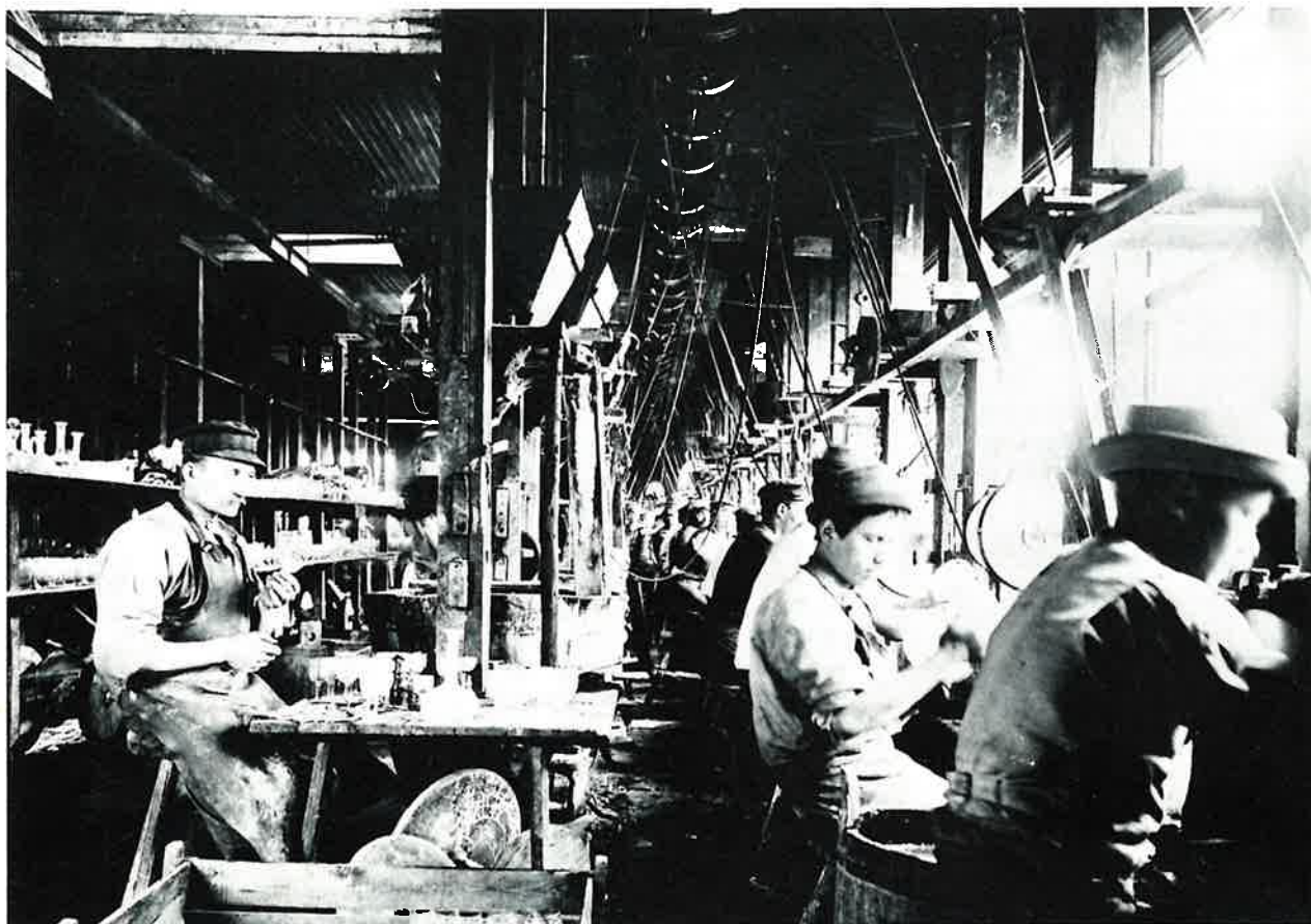
Sliperiet med remdrivna slipstolar och drivet av en lokomobil.
