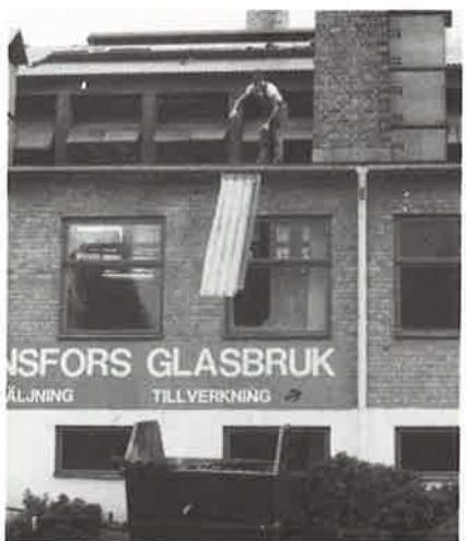
Här åter det gamla asbetsstaket av Johansfors hytta.
