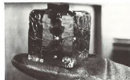
Här har Tage Möller gjutit in en »liten gubbe» i glasblocket. När glaset stelnat har »gubben» torkat och kan lätt skakas ut ur formen. Här ses resultatet av gjutningen inuti glasblocket.
