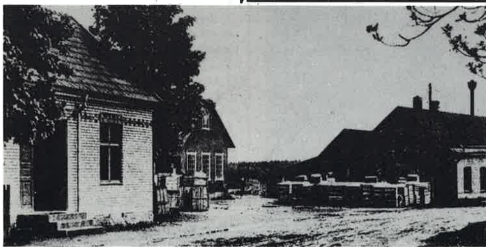
Kontorsbyggnad och sliperiet i Boda 1915
