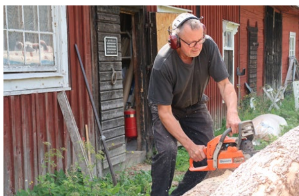
Gunnar väljer en kvistfri och fuktig del av en stock, och sågar ut ett ämne som behövs till nästa form.
