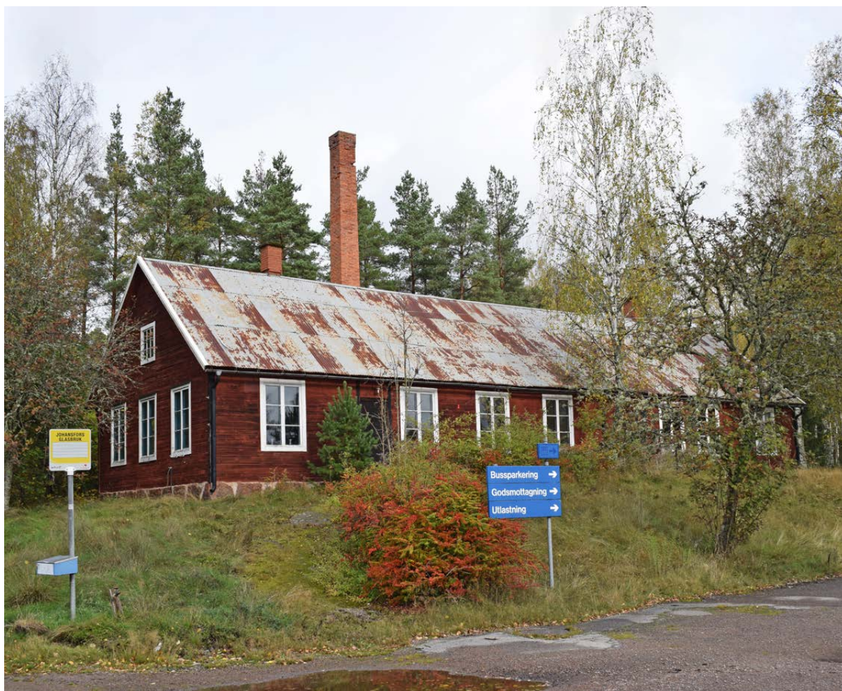
Johansfors glasmåleri från 1920. Inne i glasmåleriet från 1920 finns glasugnarna kvar, inmurade i väggarna. Även skorstenen finns kvar. Luckorna till ugnarna är dock borttagna.
